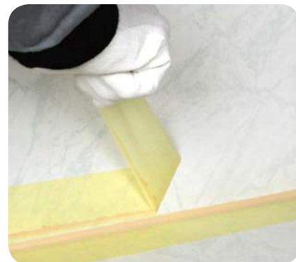
18. Ihneď po zahladení silikónového tesnenia odstránime maskovaciu pásku.
