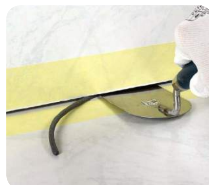
15. Spoje stena-stena a stena-podlaha oblepíme maskovaciu páskou a natlačíme do nich Murexin škárovací povrazec.
