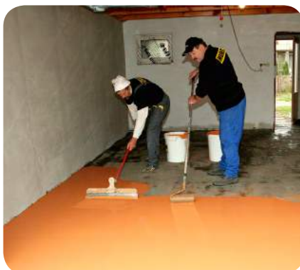
11. Ihneď po roznesení hmoty na podklad ju od-vzdušňujeme odvzdušňovacím valcom. Odstránia sa tak vzduchové bubliny, ktoré vznikli pri miešaní živice.
