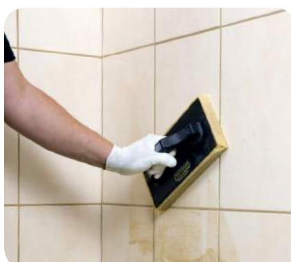
14. Po zaschnutí škárovacej malty obklad dôkladne poumývame čistou vodou a prípadné zvyšky škárovacej malty odstránime Murexin Kyselinový čistič Colo SR 30 .
